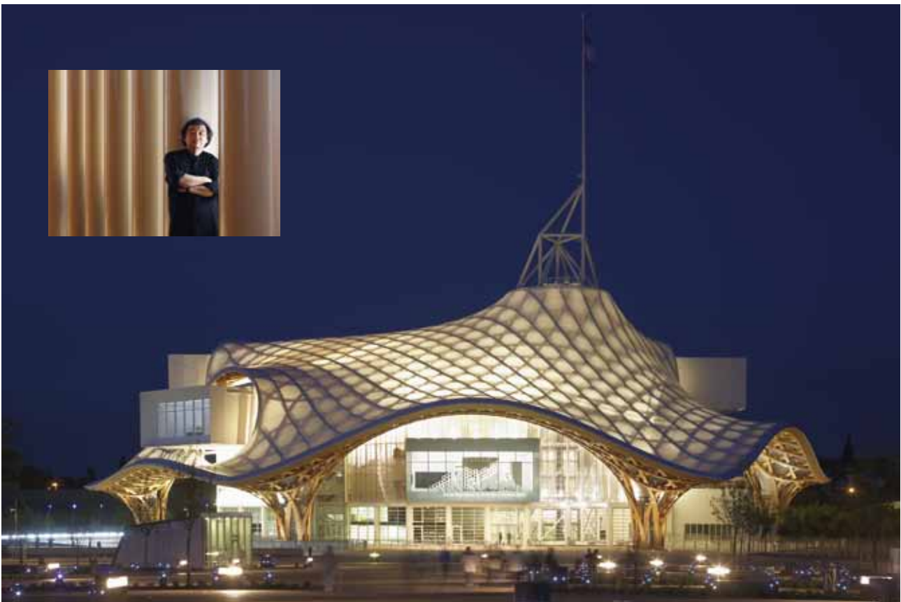
Centre Pompidou-Metz, Francia, diseñado por los arquitectos Shigeru Ban y Jean de Gastines. Fotografía: Getty Images Latin America
