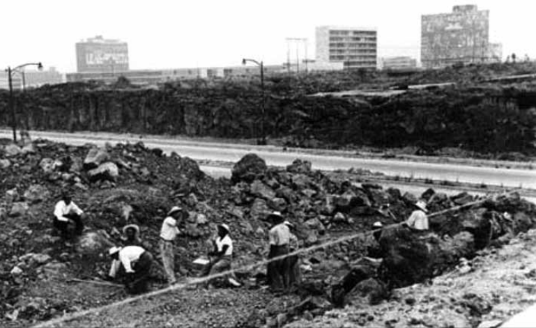
Fotografías: Archivo Histórico de la UNAM, Colección Universidad, Sección: Construcción Ciudad Universitaria, Fondo: Saúl Molina Barbosa: bit.ly/1GwflZ
